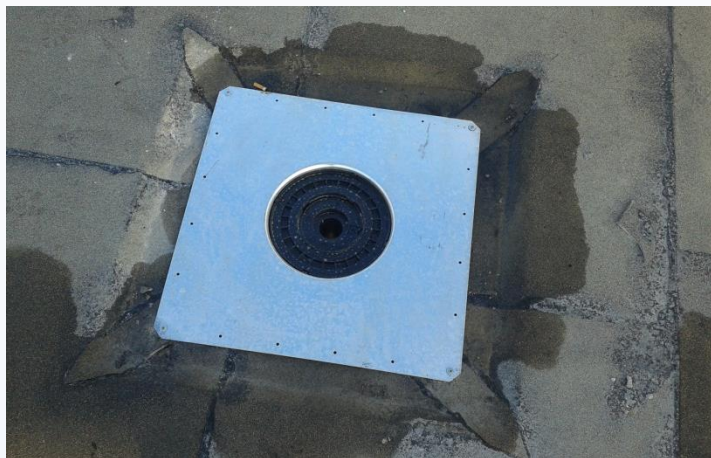
Zawilgocenie w obrębie wpustów
